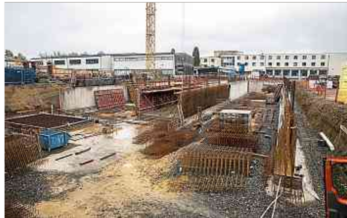
Das Gebäude, das sich zurzeit im Rohbau befindet, soll später bis zu 750 Schüler aufnehmen. Foto: Gerry Huberty
